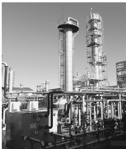
図1 HP型メタノール蒸留設備（右側奥が新設）
