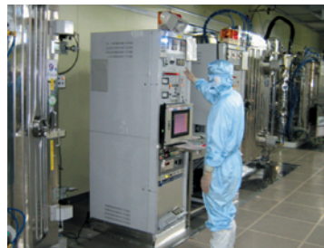
クリーンルームでの作業
