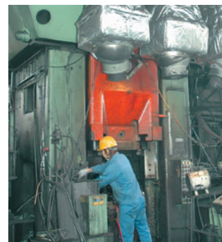
蓄熱システムに切り替えられた 作業場のスポット空調設備
