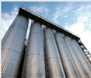
温度管理のために多くの冷水を要する巨大な貯蔵用ジャケットタンク
