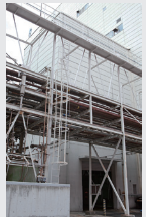
液糖貯蔵タンク室
