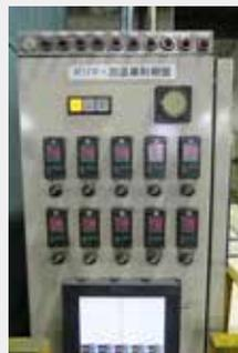
加温庫の制御盤 (各車を個別に温度制御)
