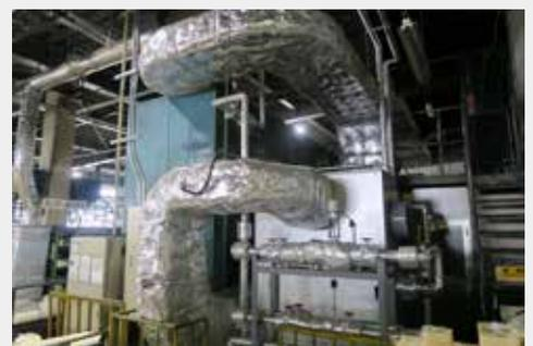
加温庫裏のAHU [熱交換器(空気-温水)を内臓] 従来の蒸気式から温水式の熱交換器に更新
