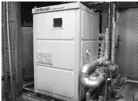
新たに導入した前川製作所のエコキュートで得られる給湯温度は90度C。引き続き約10度の昇温用として湯と冷水を同時に供給できるヒートポンプ「水熱源エコキュート」
