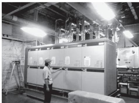
ハンドリングユニットに冷水を供給している。20年が経過したことでは、老朽化が進み、熱効率が低下してきたため、
