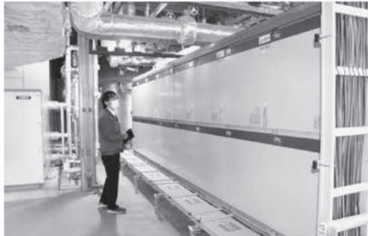
三菱電機の水冷式チラー
