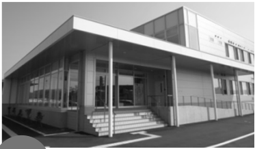
福井県 あわら市立学校給食センター 食数 3000食 オール電化
