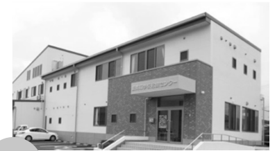
滋賀県 愛荘町学校給食センター 食数 3000食 オール電化
