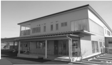
長野県 池田松川学校給食センター 食数 1800食 オール電化
