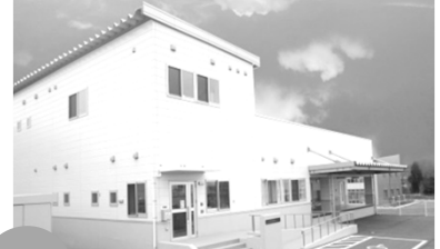
宮城県 七ヶ浜町学校給食センター 食数 2200食 オール電化
