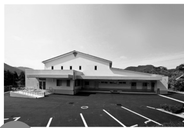
愛媛県 大洲市大洲学校給食センター 食数 4300食 オール電化
