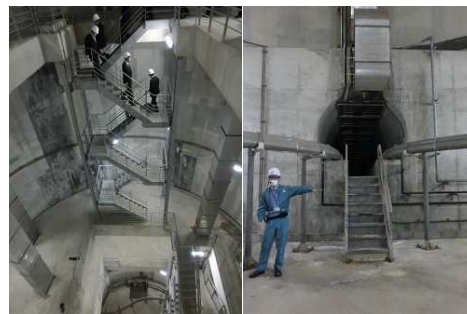
写真 5-洞道立坑を下る委員らと洞道入り口
