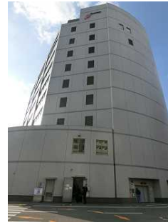
写真 1-変電所地上建物
