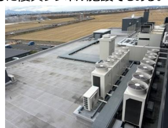
写真1 屋上のヒートポンプ機器
