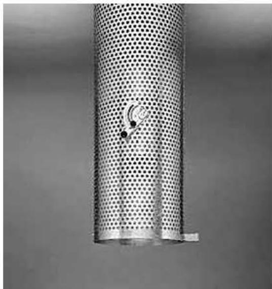
写真1 円筒型置換換気吹出口
