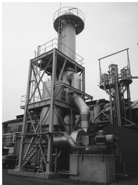
写真 1 MVR 型蒸発装置の外観
