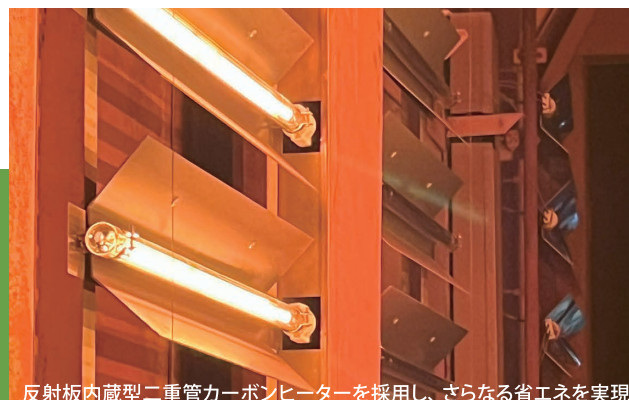
反射板内蔵型二重管カーボンヒーターを採用し、さらなる省エネを実現
