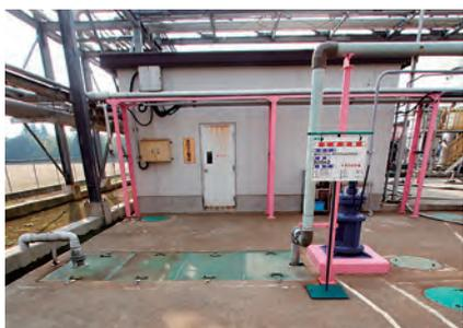
廃水処理設備の外観。水槽は地下に埋設されている。
