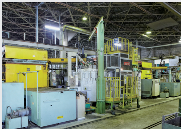
電気式アルミ溶解炉(中央)とガス式アルミ溶解炉
