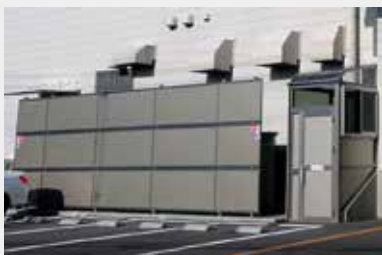
近隣住民に配慮して遮音壁を設置 (奥にエコキュートの室外機を設置)
