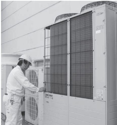
ねっぷトーンの室外機。幅を取らないため設置しやすい
