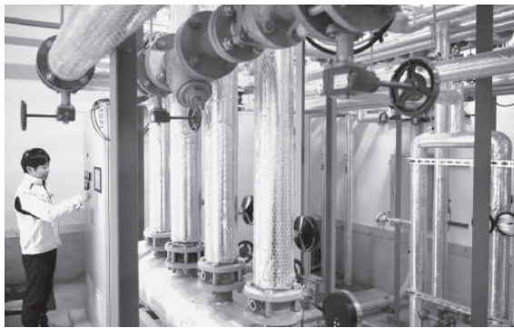
ヒートポンプは30馬力の装置を2台導入した
