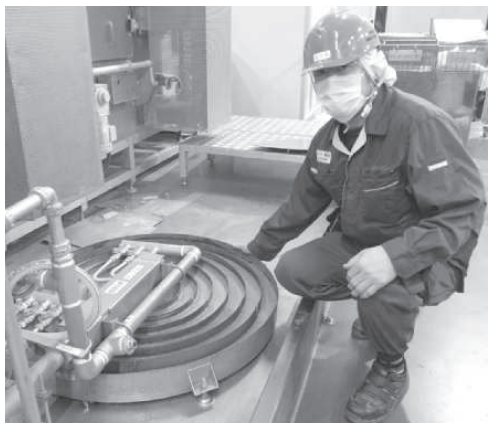
フローラウンド熱回収装置は流路幅を56ミリのまままで広げること、固形物を含む排水でも閉塞することなく連続運転を可能とした
