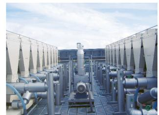
↑空気熱源ヒートポンプ(モジュール連結式)
