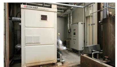
↑冷温水同時取り出しヒートポンプ(水熱源エコキュート)
